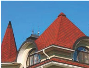
При укладке черепицы на скатах при уклоне больше 60° лист должен крепиться 6 гвоздями (2 дополнительных гвоздя фиксируют верхние углы листа на расстоянии от краев 2,5 см).
